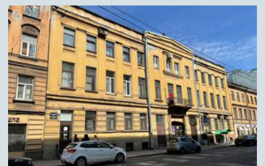
ул. Гончарная, д.16А
